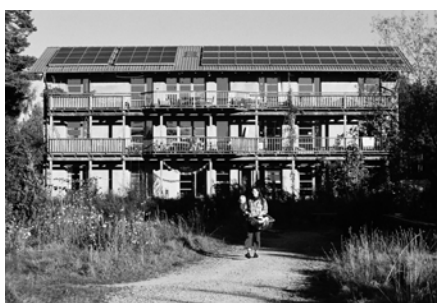
Beim Strohhallenbau übernimmt das Ökodorf Sieben Linden europaweit eine Pionierfunktion. Dazu gehört auch die dreistöckige Strohhallen-Mietkasernen »Strohpolis«.
